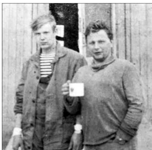
Бойцы ССО «Строитель» Павел Епифанов (слева) и Юрий Пинежский на строительстве Няндомской птицефабрики
