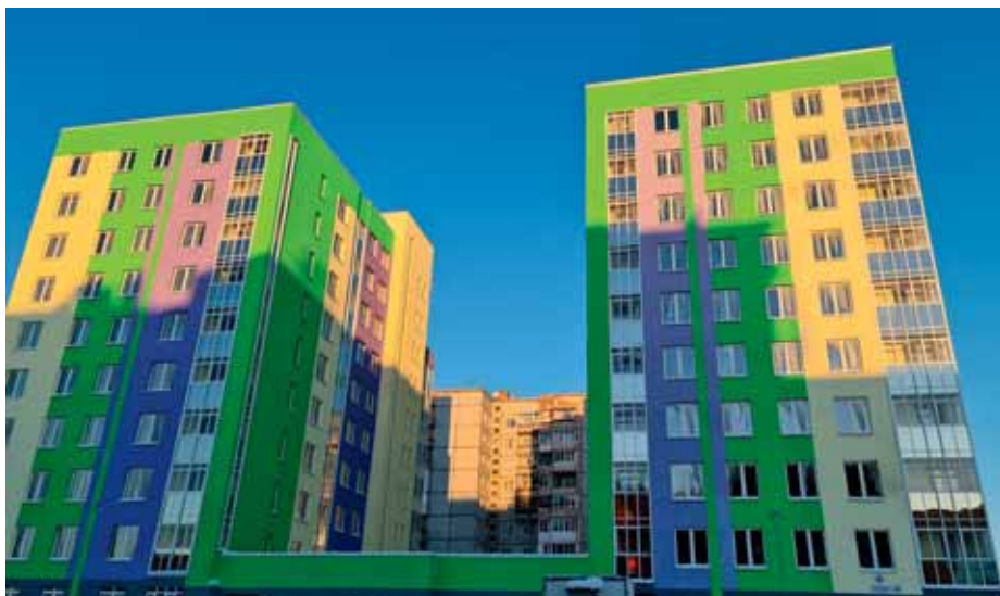
ЖК «ПАНОРАМА» НАПРОТИВ ГИПЕРМАРКЕТА «МАКСИ» НА ЛЕНИНГРАДСКОМ ПРОСПЕКТЕ. ЗАСТРОЙЩИК – ООО «ПЛАТИНУМ». ФАСАДНЫЕ РАБОТЫ – ООО «СТРОЙ ТЕХНОЛОГИИ».
