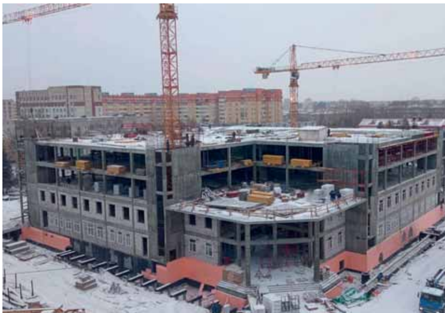
СТРОИТЕЛЬСТВО ЛЕЧЕБНО-ДИАГНОСТИЧЕСКОГО КОРПУСА ДЕТСКОЙ ОБЛАСТНОЙ БОЛЬНИЦЫ ИМЕНИ П. Г. ВЫЖЛЕЦОВА В АРХАНГЕЛЬСКЕ – ОДНА ИЗ КРУПНЕЙШИХ СТРОЙПЛОЩАДОК РЕГИОНА И ВСЕГО СЕВЕРО-ЗАПАДА РОССИИ. ЗДАНИЕ УЖЕ ЗАВЕДЕНО ПОД КРЫШУ.
