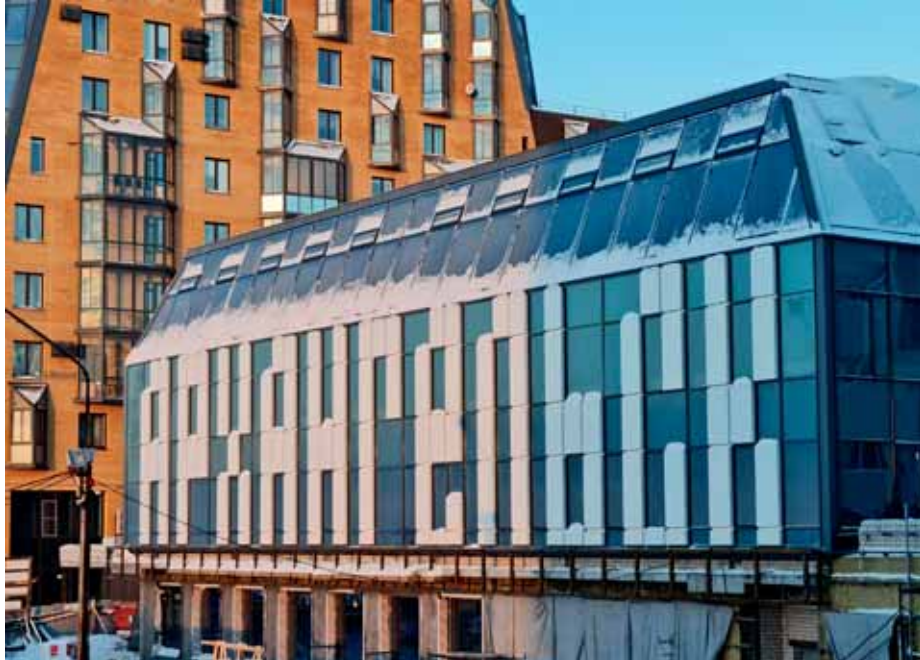
ПРОЕКТ НОВОГО РЕЧНОГО ВОКЗАЛА В ОКОНЧАТЕЛЬНОМ ВИДЕ ПОЯВИЛСЯ ДАЛЕКО НЕ СРАЗУ. СЛОЖНЫЙ ФАСАД С БУКВАМИ «АРХАНГЕЛЬСК» ИЗГОТАВЛИВАЕТ И МОНТИРУЕТ КОМПАНИЯ «СТРОЙ ТЕХНОЛОГИИ», ВОПЛОЩАЯ ЗАДУМКУ АРХИТЕКТОРА. ТРИ ИЗ ЧЕТЫРЕХ ЭТАЖЕЙ ЗАВЕРШЕНЫ, ФАСАДНЫЕ РАБОТЫ ПЛАНИРУЕТСЯ ЗАКОНЧИТЬ К ЛЕТУ 2022 ГОДА.
