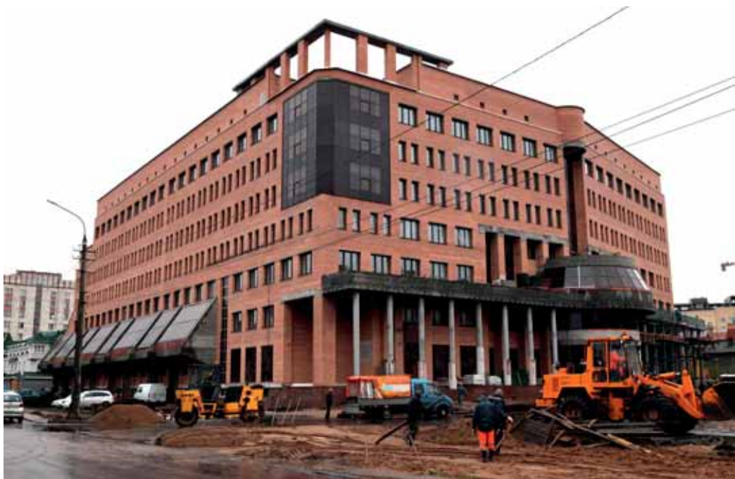
ГЕНПОДРЯЧИКОМ СТРОИТЕЛЬСТВА НОВОГО ЗДАНИЯ ОБЛАСТНОГО СУДА. ТАКЖЕ ЯВЛЯЛАСЬ АГР. ИМЕННО ЗДЕСЬ РАССМАТРИВАЮТСЯ САМЫЕ РЕЗОНАНСНЫЕ В РЕГИОНЕ ДЕЛА.
