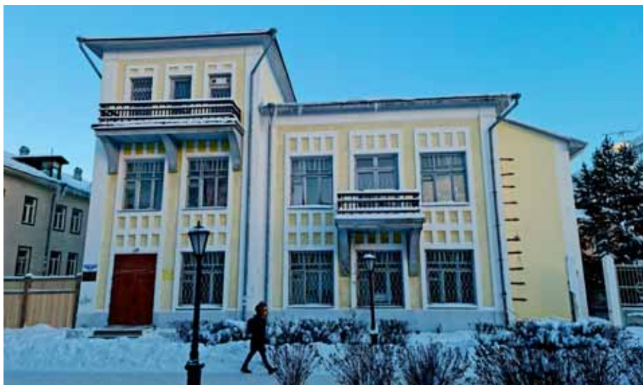
ПО ДОГОВОРУ С ФОНДОМ ИМУЩЕСТВА И ИНВЕСТИЦИЙ АРХАНГЕЛЬСКОЙ ОБЛАСТИ ООО «СТРОЙ ТЕХНОЛОГИИ» ЗАНИМАЕТСЯ РЕМОНТОМ ФАЛЬЦЕВОЙ КРОВЛИ НА ЗДАНИИ ПО АДРЕСУ: ЧУМБАРОВА-ЛУЧИНСКОГО, 20. ЭТО ПАМЯТНИК АРХИТЕКТУРЫ – КИРПИЧНЫЙ ДОМ ГОРОДСКОЙ УСАДЬБЫ Ф. Г. АНТОНОВА, ПОСТРОЕННЫЙ В 1914 ГОДУ.
