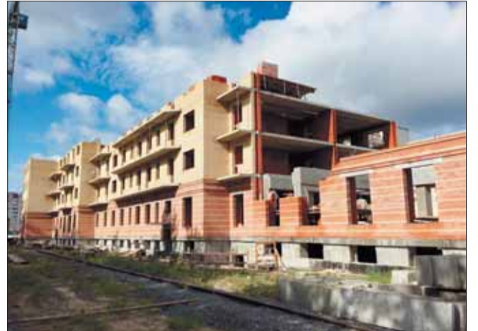
На стройплощадке ЖК «PARUS» полностью завершена нулевой цикл. Ведутся работы по возведению первой очереди жилого комплекса на 217 квартир. Половина из них уже куплена северодвинцами.
