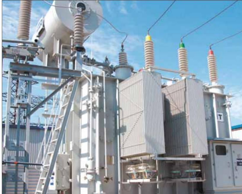
В настоящее время энергетики запустили в работу вторую часть открытого распределительного устройства 110 кВ и трансформатор мощностью 25 МВА. Для завершения проекта специалистам необходимо закончить установку оборудования 6 кВ, перезавести кабели на новое распределительное устройство 6 кВ и демонтировать старое оборудование.
